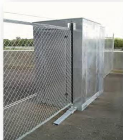
Abb. 17: mobiles Rollzaunsystem Zuwegung
