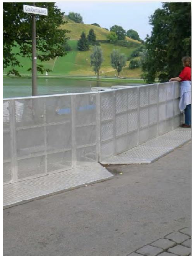
Abb. 9: Absperrung vor einem abfallenden Hang - Vorderansicht
