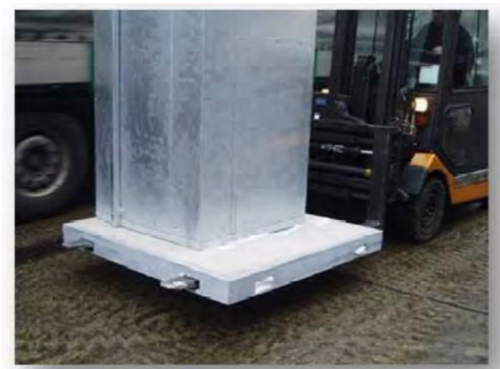
Abb. 18: Transport des mobilen Rollzauns
