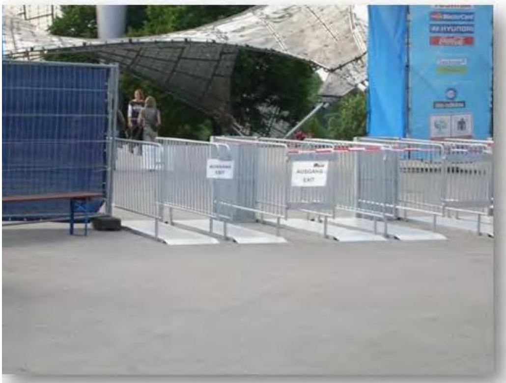
Abb. 6: weiteres Beispiel zur Anwendung: Einlassschleuse aus Absperrgittersystem außerhalb der Rettungswege.
