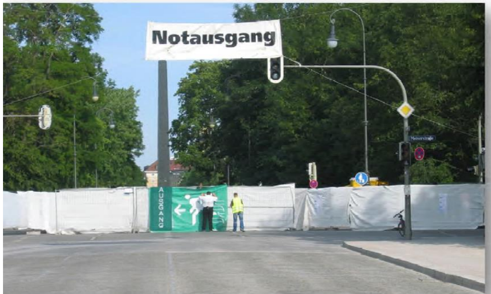
Abb. 3: Bauzaun als Sichtschutz mit Notausgangskennzeichnung; zu beachten sind mögliche Windlasten, die auf die Banner einwirken können.
