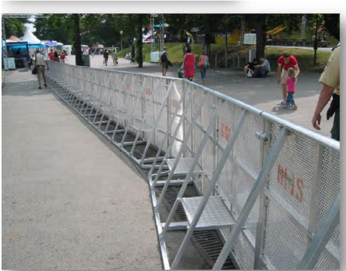
Abb. 10: Absperrung innerhalb eines Stehplatzbereiches – Rückansicht
