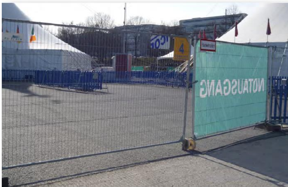
Abb. 7: Flucht und Rettungsweg mit Kennzeichnung in Bauzaunfeld auf Rollen gelagert (außerhalb der Betriebszeit)
